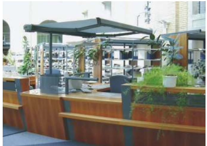
Elektromotorisch ausfahrbare Markisen zum Schutz vor Sonneneinstrahlung und Wärme für Mitarbeiter an der Thekenanlage im Lesesaal Lichthof Ost
