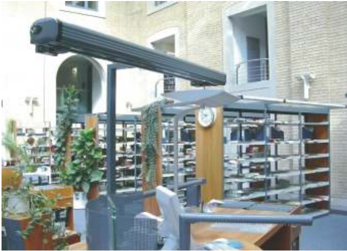
Elektromotorisch ausfahrbare Markisen zum Schutz vor Sonneneinstrahlung und Wärme für Mitarbeiter an der Thekenanlage im Lesesaal Lichthof Ost
